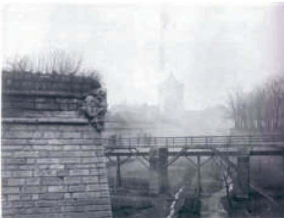
Die Wöhrder Bastei mit Blick auf das Laufer Tor, ca. 1871, Foto von Ferdinand Schmidt
