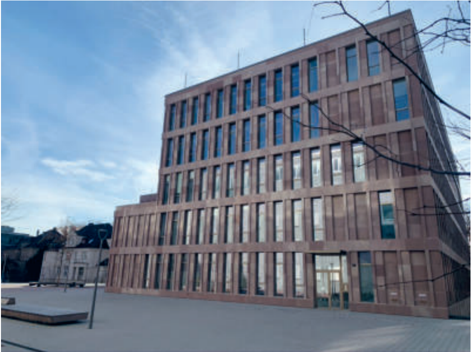
Abbildung 1: Der Neubau der Georg-Simon-Ohm-Hochschule am Prinzregentenufer in Wöhrd
